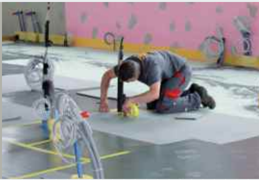
Fugenverklebung
