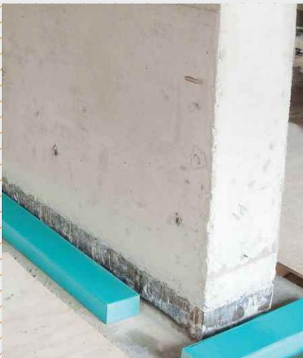
Einbaudetail der punktförmigen Lagerung des Zwischengesosses. Lagerabmaße individuell ausgelegt in Abhängigkeit von vorgegebenen Wirksamkeitsanforderungen und spezifischer Belastung.
