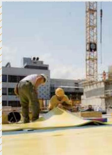
Entsprechend der Lastabtragung durch die tragenden Wände wurden Sylomer®-Werkstoffe mit unterschiedlicher Steifigkeit eingesetzt. Zwischen diesen steifen Auflagern wurde ein weicher Sylomer®-Werkstoff (gelb) als Füllmaterial eingebaut. Die Stärke der Bodenplatte beträgt bei diesem Projekt 20 cm.
