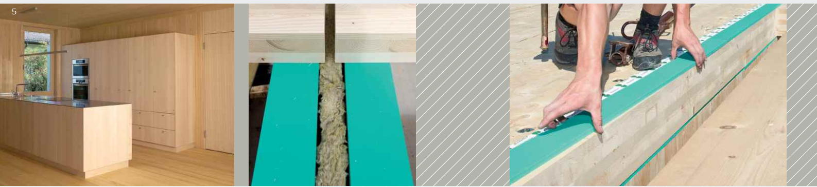
Elastische Lagerung von Wand und Decke
