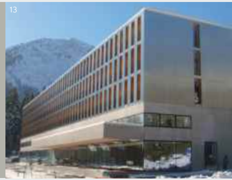
Alpenhotel Ammerwald, BMW Group in Modulbauweise
