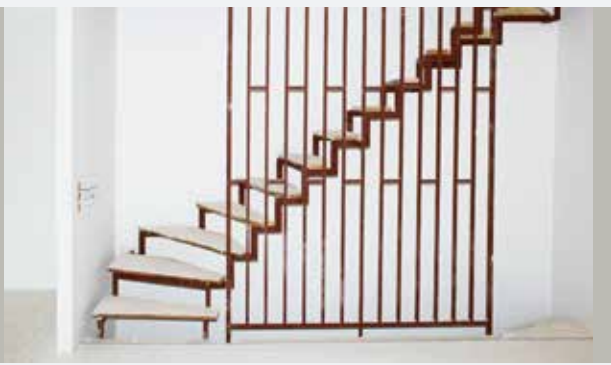
Enkoppelte Harfentreppe im Rohbau
