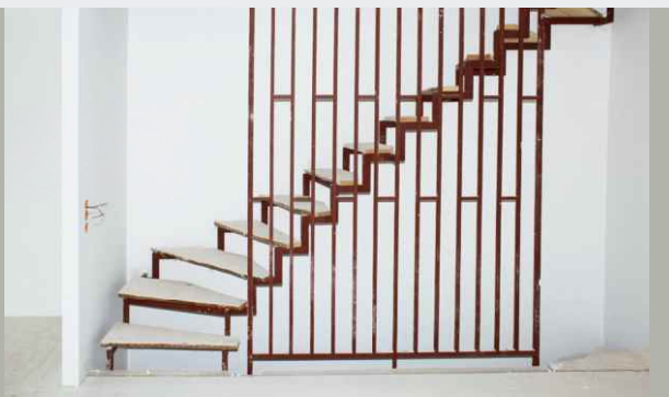
Enkoppelte Harfentreppe im Rohbau
