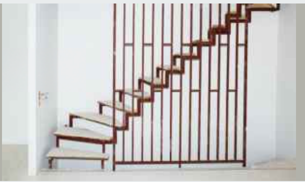
Enkoppelte Harfentreppe im Rohbau
