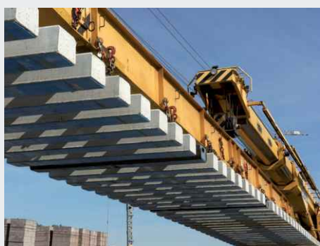
Train de montage avec traverses équipées de semelles
