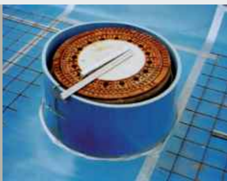
Isolation d'un système masse-ressort d'une canalisation
