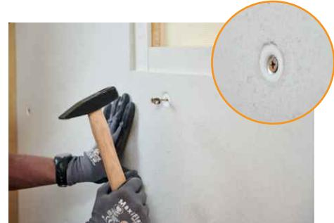
**4** Beginnen sie mit der Montage von unten links. Die Feder der ersten Platte ist auf der kurzen und langen Seite abzuschneiden. Bei den darüberliegenden Platten nur auf der Langen Seite.
