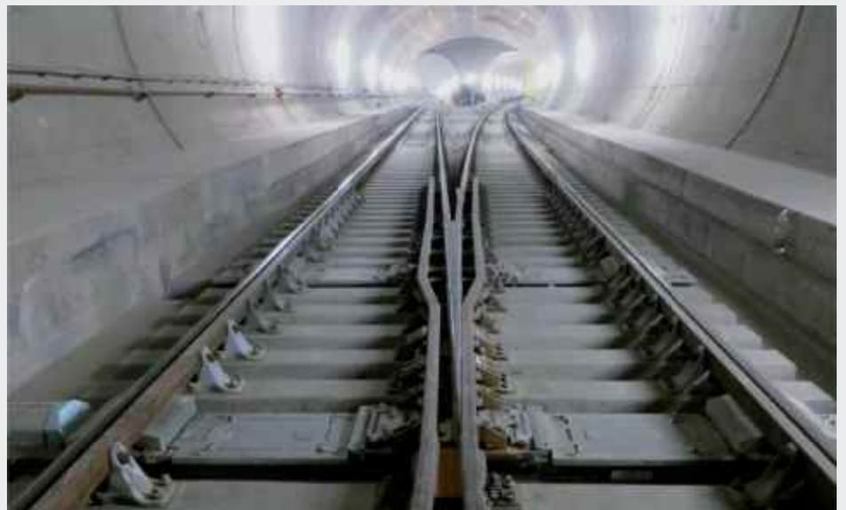
マススプリングシステムが敷設されている分岐器
