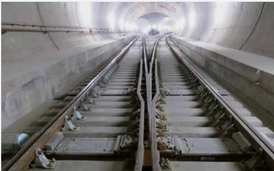
マススプリングシステムが敷設されている分岐器
