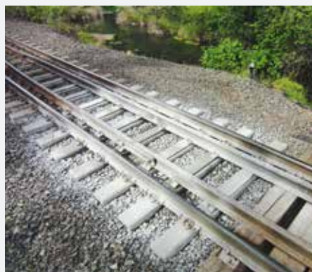
分岐器での不均一な荷重分散により摩滅したバラストと、白くなった周辺部
