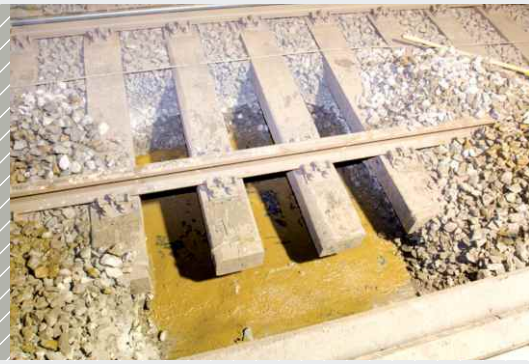
道床を取り除いた底面に見られるバラストマット
