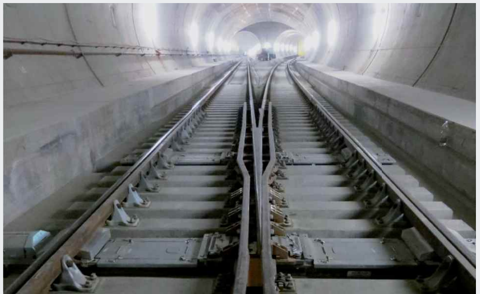
Auf Masse-Feder-System gelagerte Weiche
