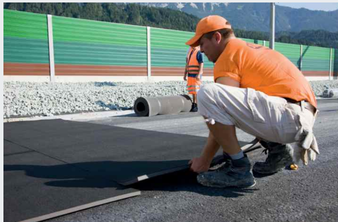
Verlegen von Unterschottermatten
