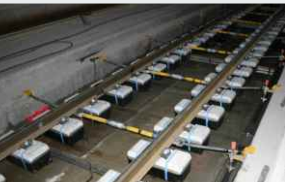
精调后的轨道
