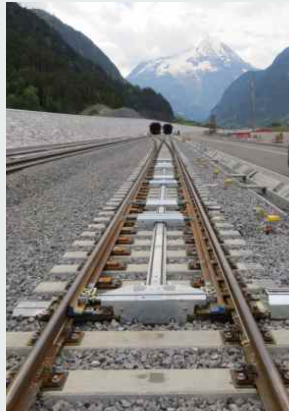
隧道洞口道岔区
