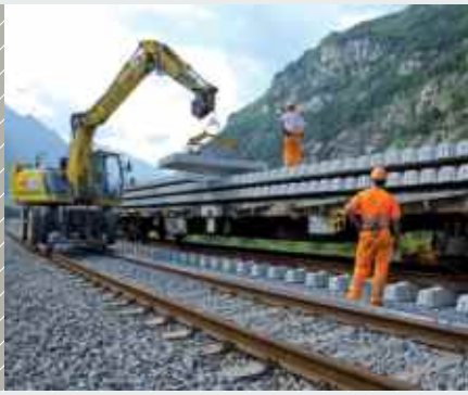
隧道洞口连接线采用有砟轨道
