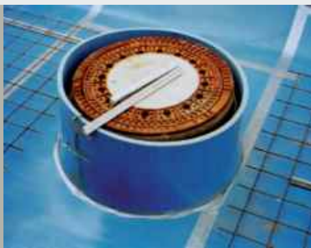
质量弹簧系统相 对排水系统的隔离
