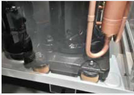
Lagerung einer Kompressorenbaugruppe auf einem Innenrahmen
