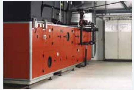
Im Keller aufgestellte RLT-Anlage
