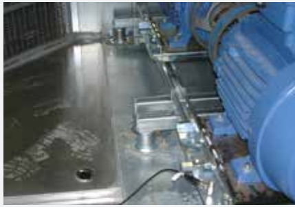
Lagerung von riemengetriebenen Ventilatoren
