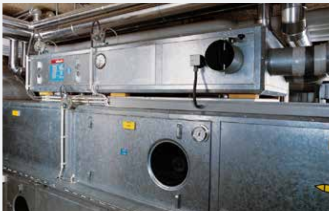
Entkoppelte Module eines Lüftungsgerätes
