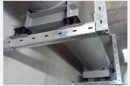
Lagerung Rohrschalldämpfer
