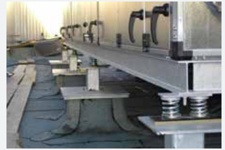
RLT auf Dach installiert
