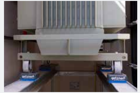
Schwingungsentkoppelte Lagerung eines Verteiltransformators
