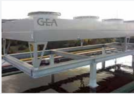
Rückkühler mit Isotop® DZE zur Absicherung von sehr hohen Windlasten
