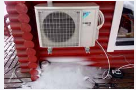
Außeneinheit einer Wärmepumpe auf Wandhalterung
