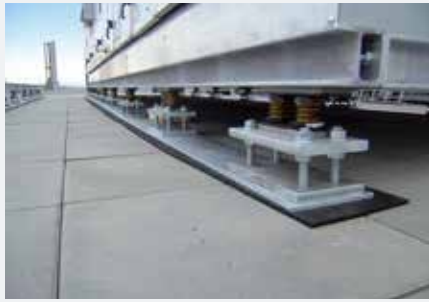
Auf-Dach Installation einer RLT-Anlage mit höheren Windlasten
