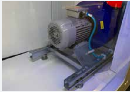
Axialventilator in einer RLT-Anlage
