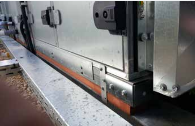
Streifenlager für ein raumlufttechnisches Gerät (RLT)
