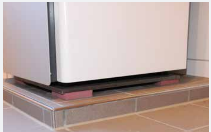
Entkopplung einer Wärmepumpen Inneneinheit
