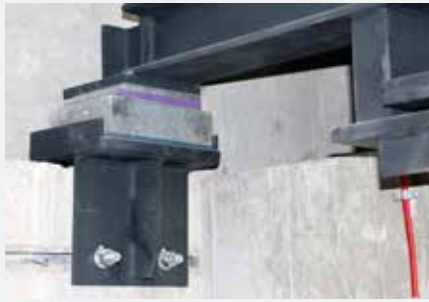
Lagerung einer Aufzugsanlage mit Seilträger im Schachtkopf
