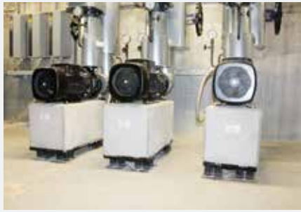
Pumpenlagerung mit zusätzlicher Masse
