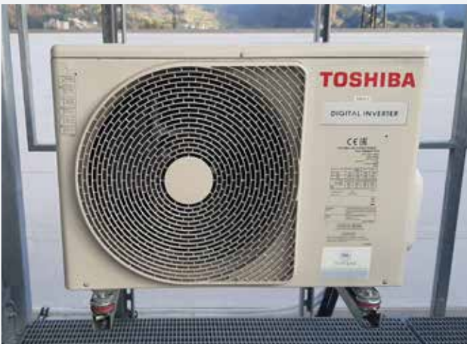
Klimagerät Außenheit auf Wandhalterung
