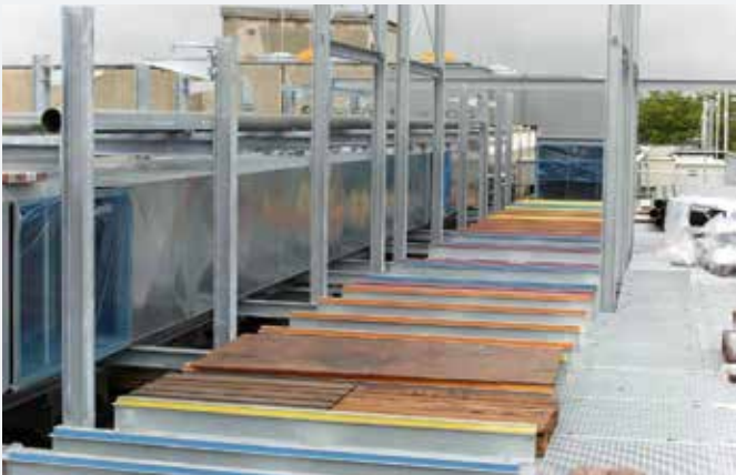
Vorbereitete Streifenlager für ein Auf-Dach Lüftungsgerät
