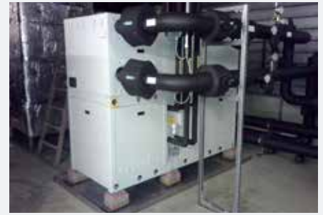
Inneneinheit Kältemaschine
