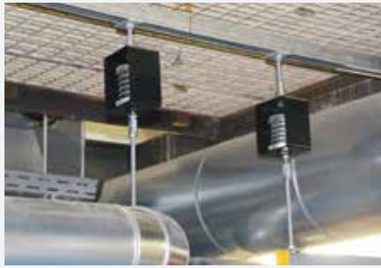
Entkoppelte Rohrleitungen mit SD/Z
