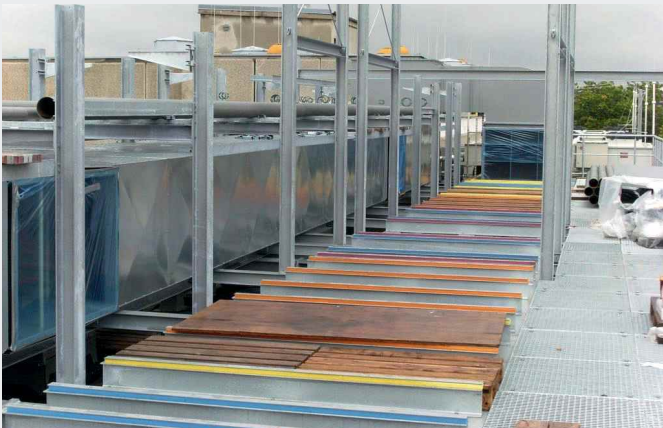
Vorbereitete Streifenlager für ein Auf-Dach-Lüftungsgerät
