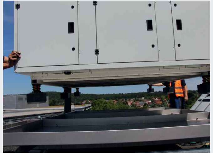
Geräteaufstellung mit vormontierten Isotop® DT
