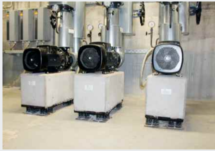
Pumpenlagerung mit zusätzlicher Masse
