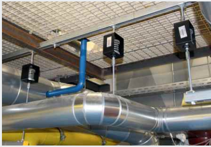
Aufhängung Rohrleitung mit Isotop® SD/Z
