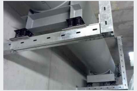
Lagerung Rohrschalldämpfer
