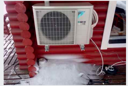
Außeneinheit einer Wärmepumpe auf Wandhalterung
