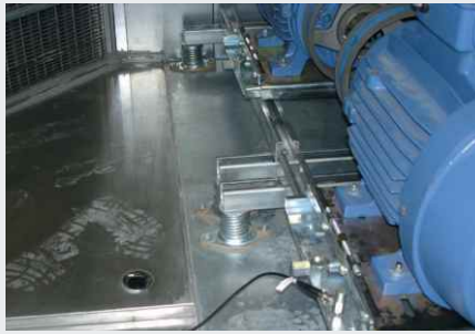
Lagerung von riemengetriebenen Ventilatoren
