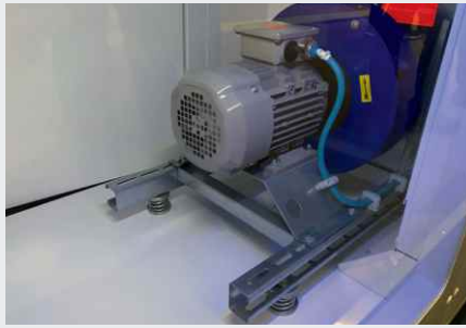
Radialventilator in einer RLT-Anlage
