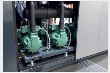
Lagerung eines Klimageräts mit Isotop® SD und Isotop FP/K
