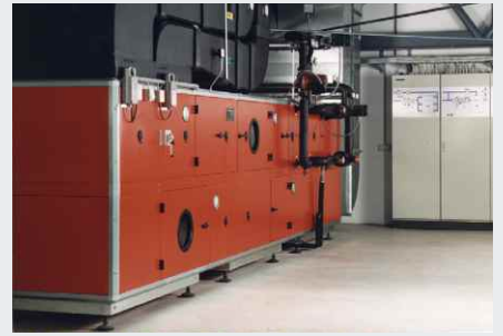
Im Keller aufgestellte RLT-Anlage
