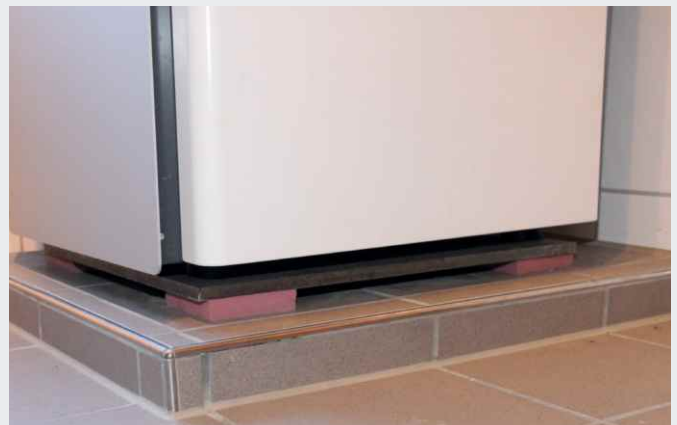
Entkopplung einer Wärmepumpen Inneneinheit
