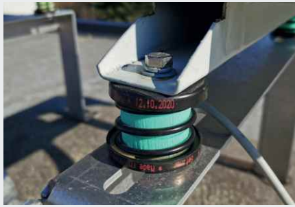
Monoblock Wärmepumpe mit Isotop® DMSN
