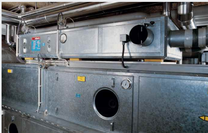
Entkoppelte Module eines Lüftungsgerätes
