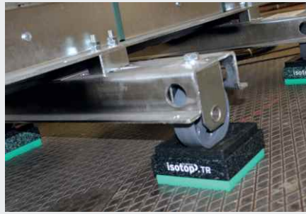
Schwingungsentkoppelte Lagerung eines Verteiltransformators
