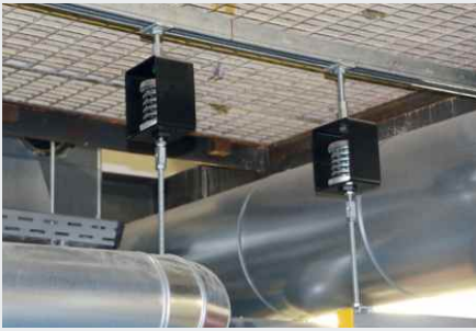
Entkoppelte Rohrleitungen mit Isotop® SD/Z
