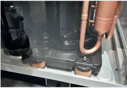
Lagerung einer Kompressorenbaugruppe auf einem Innenrahmen
