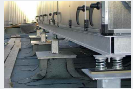
RLT auf Dach installiert
