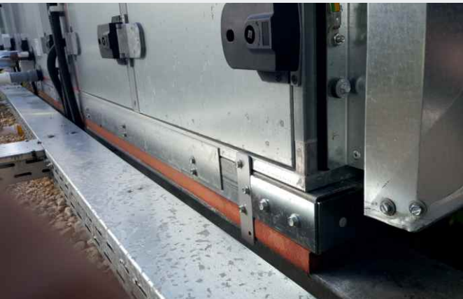
Streifenlager für ein raumlufttechnisches Gerät (RLT)
