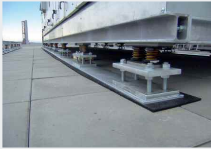
Auf-Dach-Installation einer RLT-Anlage mit höheren Windlasten
