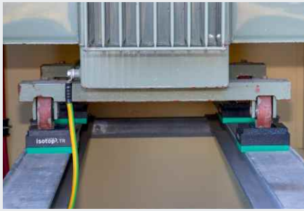
Schwingungsentkoppelte Lagerung eines Verteiltransformators
