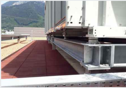
Rückkühler mit Isotop® DZE gegen hohe Windlasten
