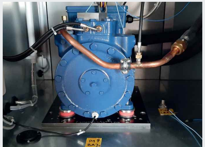
Lagerung eines Hubkolbenkompressors mit Isotop® Compact
