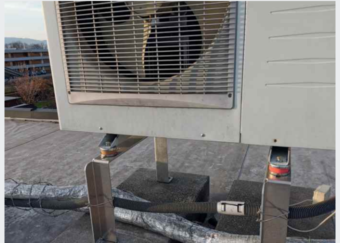
Wärmepumpenlagerung mit Isotop® Compact
