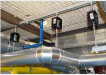
Aufhängung Rohrleitung mit Isotop® SD/Z
