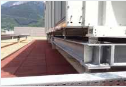
Rückkühler mit Isotop® DZE gegen hohe Windlasten
