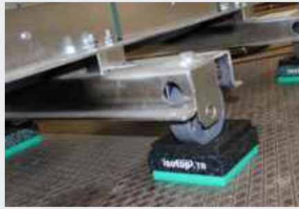
Schwingungsentkoppelte Lagerung eines Verteiltransformators
