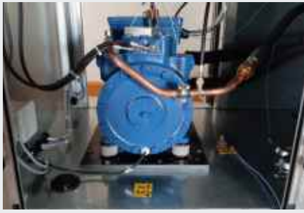
Lagerung eines Hubkolbenkompressors mit Isotop® MSN-DAMP
