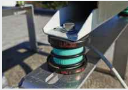
Monoblock Wärmepumpe mit Isotop® DMSN
