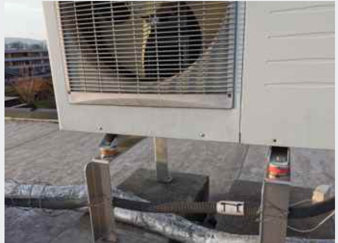
Wärmepumpenlagerung mit Isotop® Compact
