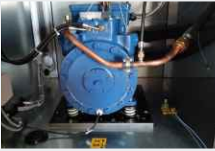
Hubkolbenkompressor mit Isotop® DMSN
