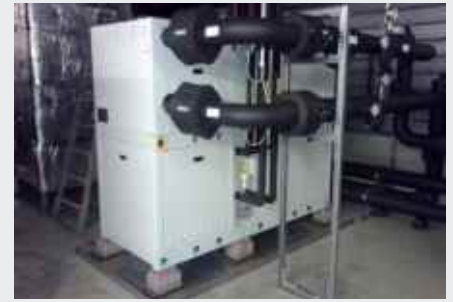
Inneneinheit Kältemaschine
