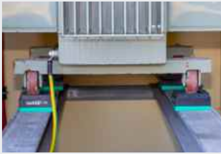
Schwingungsentkoppelte Lagerung eines Verteiltransformators
