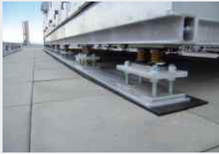
Auf-Dach-Installation einer RLT-Anlage mit höheren Windlasten
