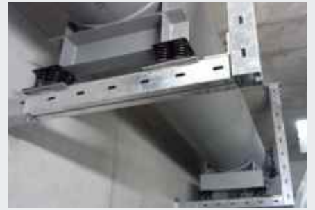
Lagerung Rohrschalldämpfer
