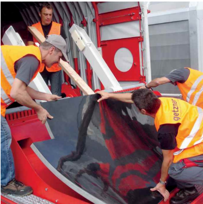
Einbau der elastischen Muldenauskleidung mit Sylomer®
