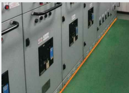
作業船の配電ユニットの防振
