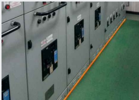
作業船の配電ユニットの防振
