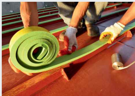
Sylomer® MarineはIMO/SOLAS認定の防振素材です。
