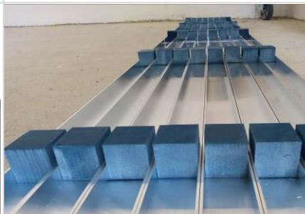
**4b)** Alternative : les Floor Blocks peuvent être insérés, à écart correspondant, dans un profil en U adapté. Ces profils devront ensuite être posés aux positions indiquées sur le plan de positionnement.
