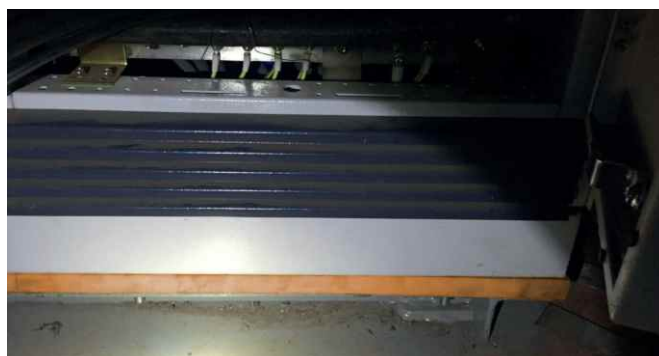
Sylomer® をフレームの直下に設置します
