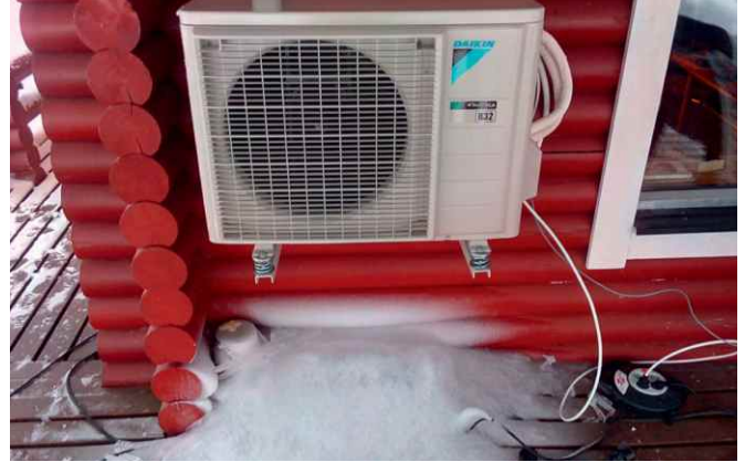
Lagerung einer hängenden Ausseneinheit mit Isotop® MSN-Elementen
