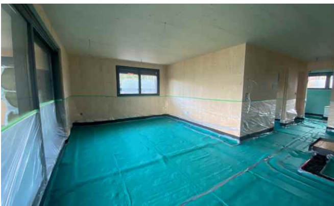
GREI: Recycelte EPDM-/SBR-Schicht zur Reduktion von Trittschall
