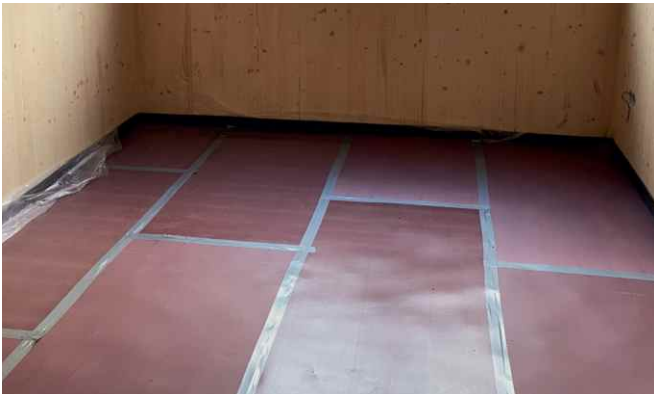
AFM35: Tieffrequente Trittschalldämmung für optimalen Schwingungsschutz
