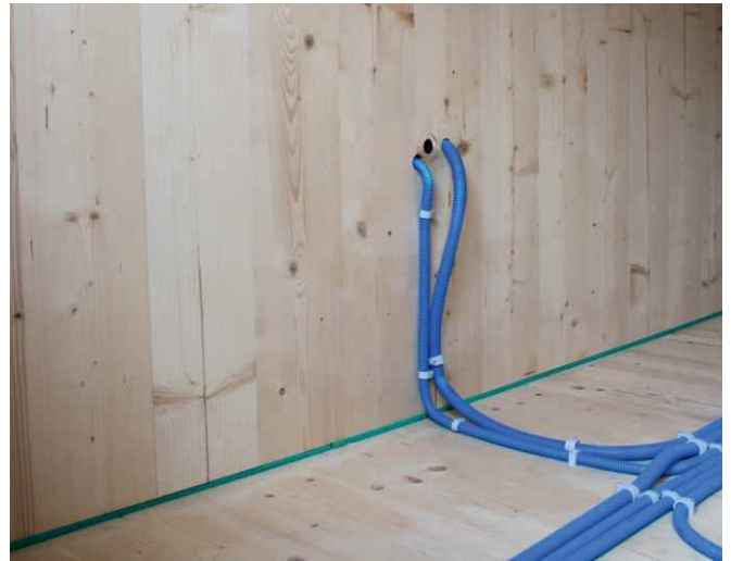
Sylodyn®-Streifenlager: Für die Flankenschallentkopplung und mehr Privatsphäre in den Innenräumen
