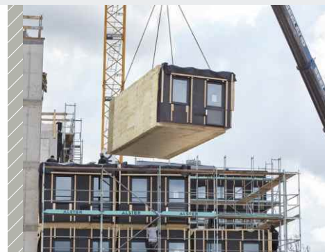
Assemblage des modules en bois massif préfabriqués
