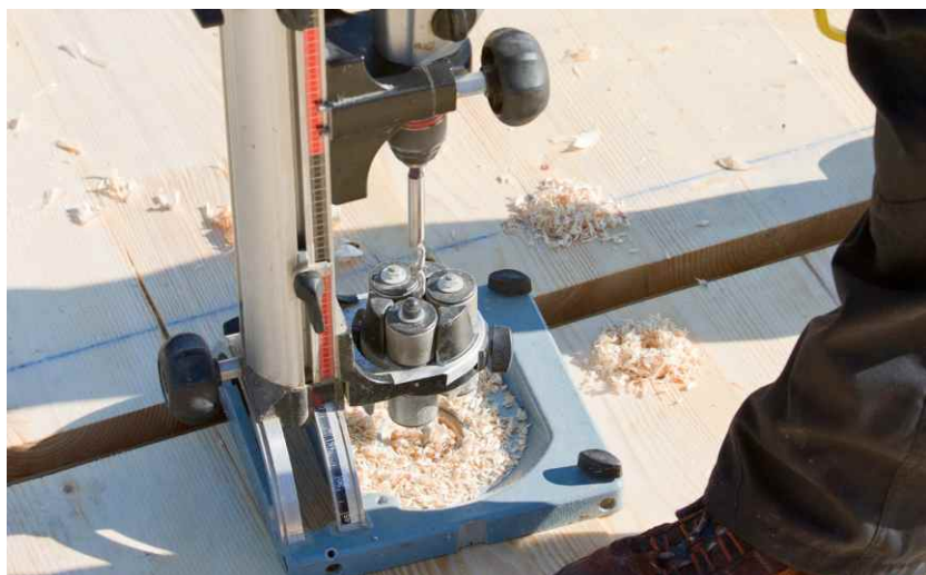
Fig. 4 : Pré-perçage
