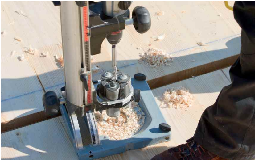
Fig. 4 : Pré-perçage
