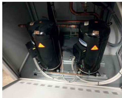
Compressori integrati nel sistema
