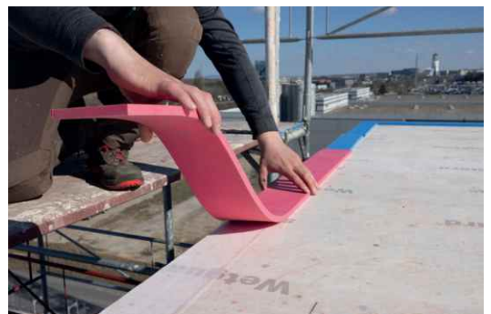
Sylodyn®-Streifen sind einfach zu verlegen. Sie sind vorgefertigt auch in einer selbstklebenden Variante erhältlich.
