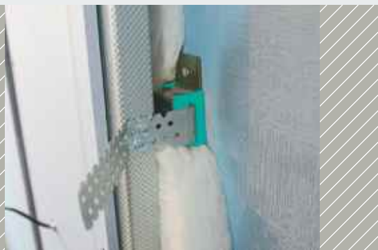
Paneli odvojeni proizvodom Sylomer® za visoku zvučnu izolaciju
