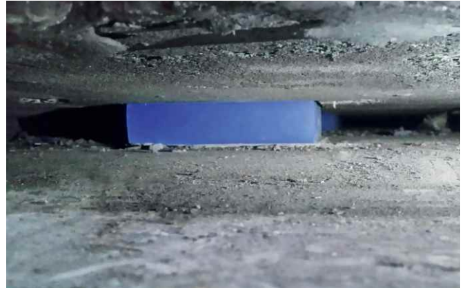
Masse-Feder-System mit Punktlagern aus Sylodyn®
