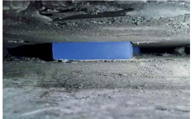
Masse-Feder-System mit Punktlagern aus Sylodyn®
