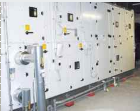
Klimatizacijski uređaj postavljen na elemente Isotop® SE
