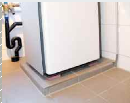
Točkasta Sylomer® izolacija za toplinsku pumpu
