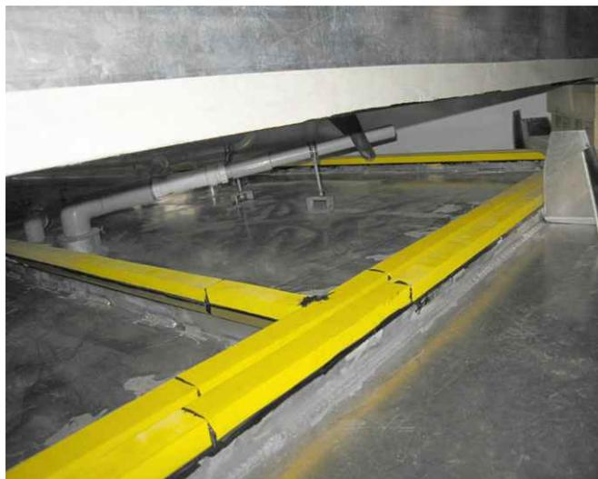
Sylomer® Streifen zur Entkopplung des gesamten Fahrerhauses
