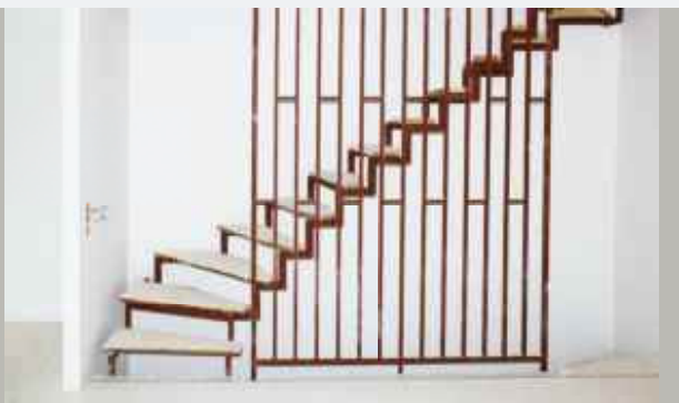
Винтовая лестница без отделки, выполненная с защитой от ударного шума
