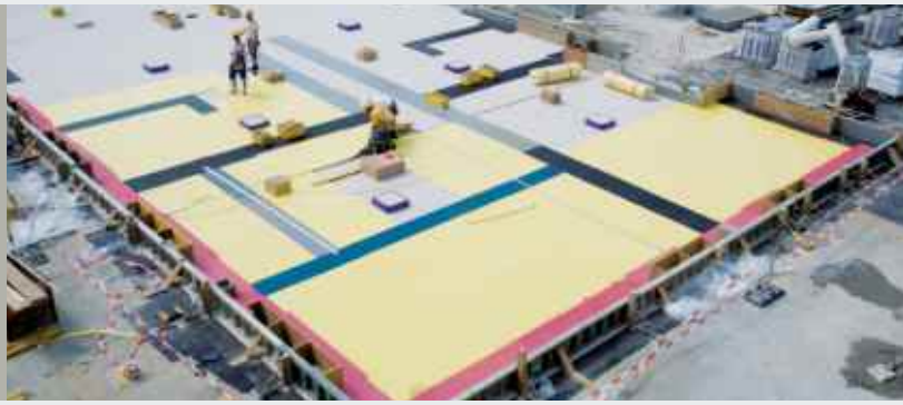
Drachen Center Basilea: Isolamento su tutta superficie dell'edificio
