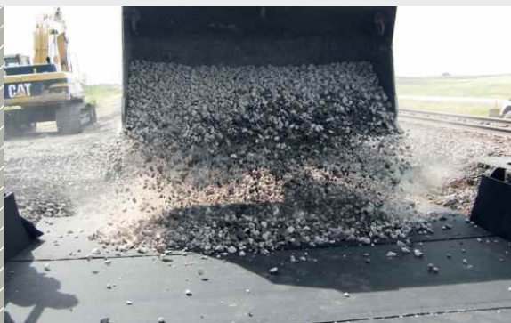
在美国的一座桥梁上安装道砟垫
