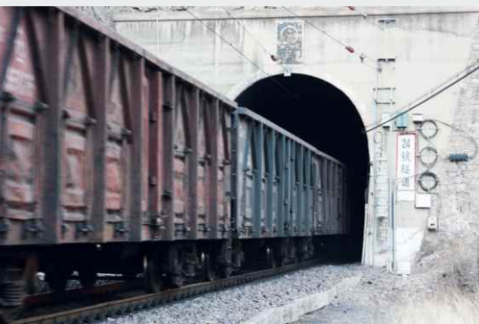
路基到隧道的过渡段
