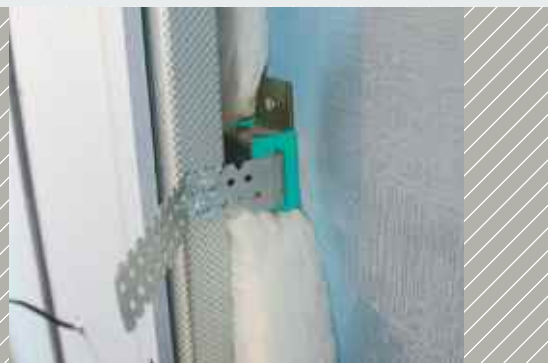
Gipszkartonfal elválasztása Sylomer® anyaggal a nagy zajtompítási hatékonyság érdekében
