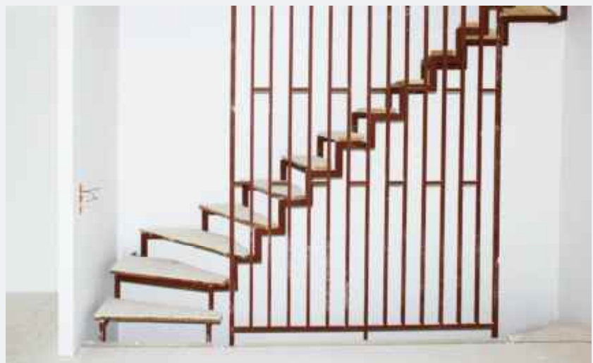
Entkoppelte Harfentreppe im Rohbau
