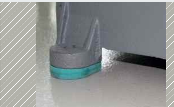
機械脚部の防振材
