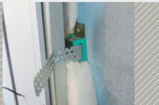
Przedścianki izolowane za pomocą materiału Sylomer® dla uzyskania lepszej izolacyjności
