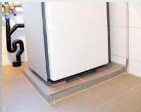
Punktowe posadowienie pompy ciepła na materiale Sylomer®
