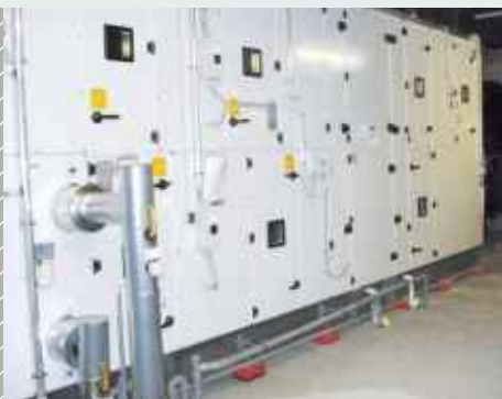
Centrala wentylacyjna posadowiona na izolatorach Isotop® SE.
