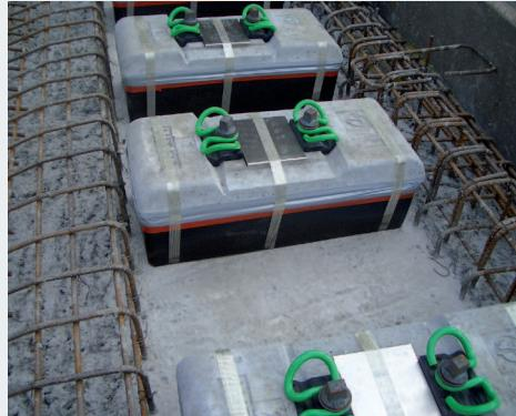
Für Weichen in der Festen Fahrbahn bestehen unterschiedliche Konstruktionsvarianten sowie mehrere Möglichkeiten die geforderten Eigenschaften hinsichtlich der Elastizität sicherzustellen. Beim System mit Langschwellen werden hochelastische Einlagestreifen aus Sylomer® und Sylodyn® unterhalb der Schwellen in so genannte Schwellenschuhe eingebracht. Die derart eingepackten Schwellen werden anschließend einbetoniert. Die unterschiedlichen Schwellenlängen bedingen wechselnde Lastabtragungsflächen.
