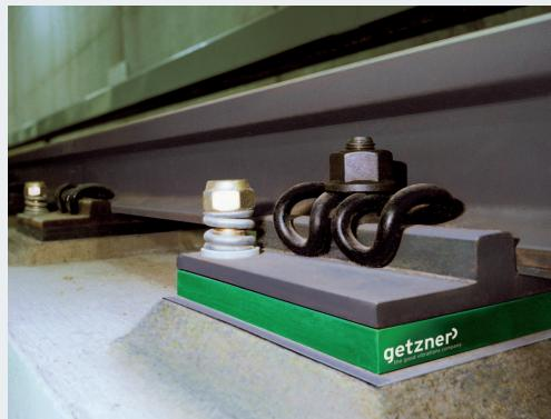
Durch Unstetigkeitsstellen, wie Herzstücke innerhalb einer Weiche, entstehen dynamische Stöße bei Zugüberfahrt, die den gesamten Oberbau zusätzlich belasten. Unterschiedlich große Rippenplatten erfordern besondere Aufmerksamkeit bei einer elastischen Lagerung mittels Zwischenplatten.
