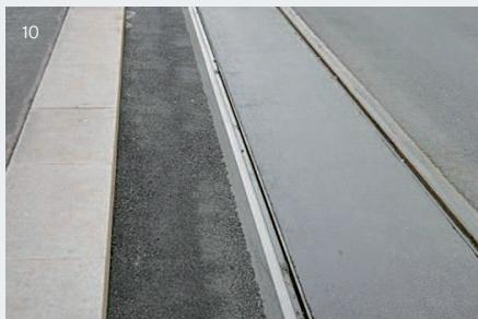
**Étape 5 :** Les joints de dilatation entre les sections de voie et la voie sont comblés avec un matériau à élasticité durable (Photo 10).
