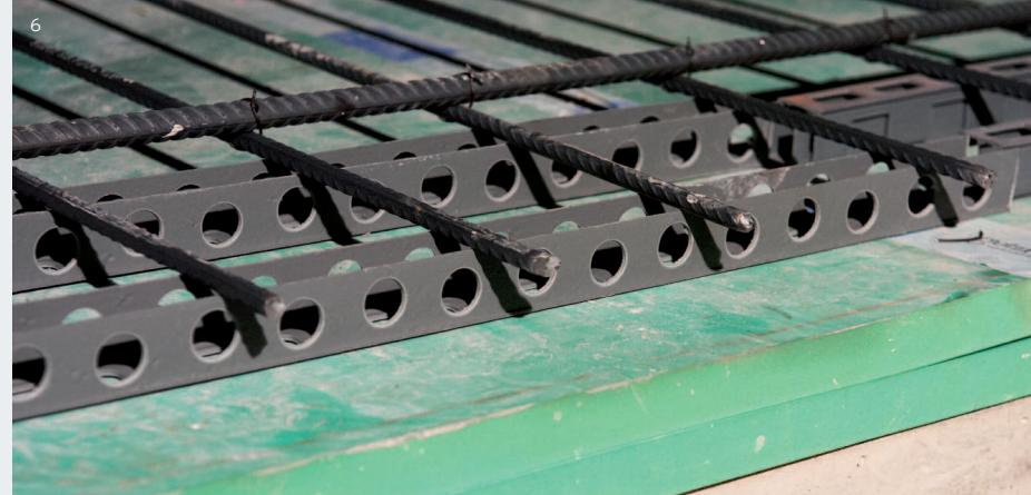
**Étape 2 :** Après cette préparation, la couche élastique fait office de coffrage perdu. L'éventuelle armature nécessaire sera mise en place en veillant également à ce que les tapis ne soient pas endommagés. Un support de base adéquat (plaques en bois ou en matière plastique) empêche des pressions spécifiques et des déflexions localisées trop importantes (Photo 6).
