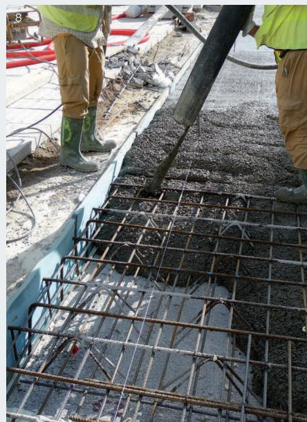
**Étape 3 :** Le béton de la dalle-support est coulé, compacté et nivelé (Photos 7, 8).
