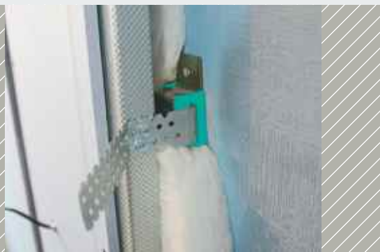
Sylomer®(シロマー)を使った乾式仕上による振動対策が高い減衰効果を発揮
