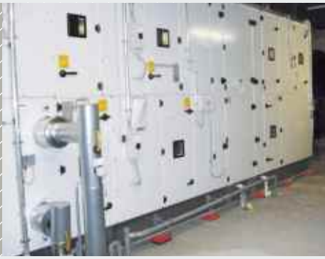
Isotop® (アイソトッ) SEエレメントを支持材として利用する空調システム
