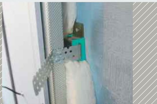
Doublages décollés avec Sylomer® pour un excellent effet isolant
