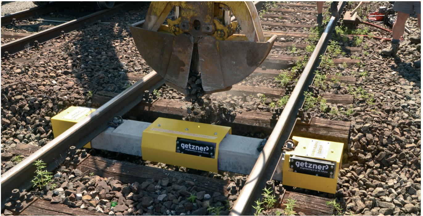
Bild 1: Aus drei Elementen bestehende Sensorschwelle beim Einbau in das Gleis
